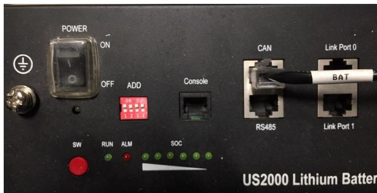
Figura 9 - Connessione cavo di comunicazione sulla batteria Pylontech
