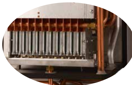
Bruciatore raffreddato ad acqua Low NO x
